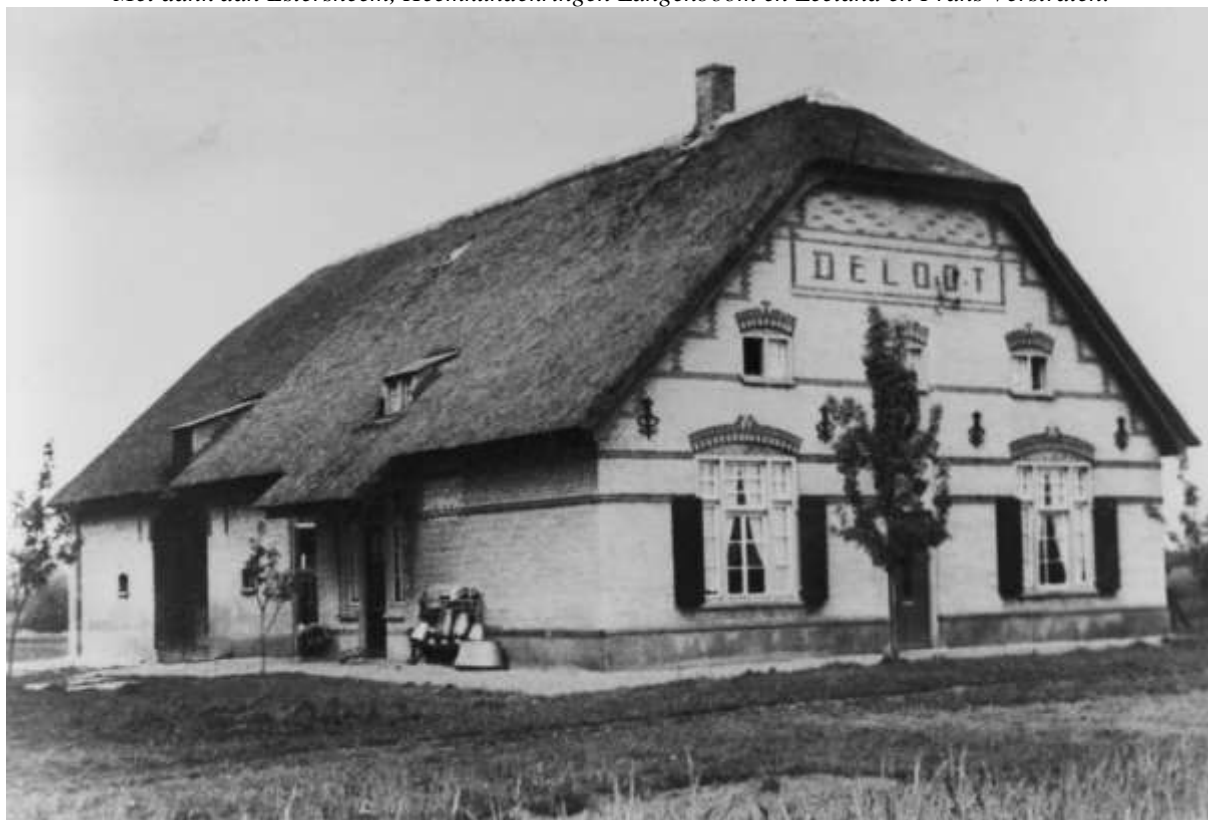
Bouwhof, voormalig Abdijgoed/Kroondomein 'De Logt' te Escharen in 1948 (herbouwd ca. 1908).
