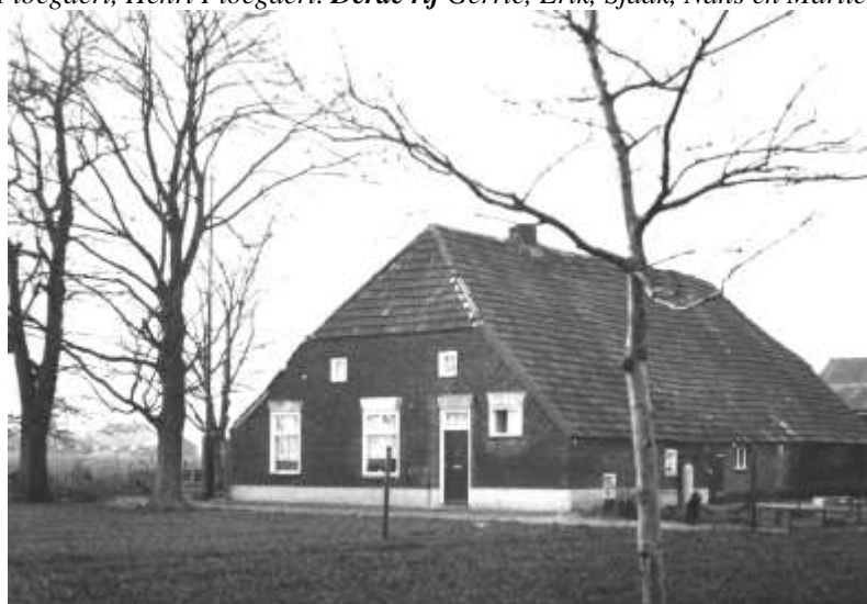
Boerderij aan de Hoogeindsestraat te Rijkevoort (ca. 1972 afgebroken)
