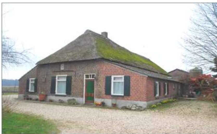
Lageheiweg 1 (F 149) Den Hoek. Zonder de zij-uitbouwen zien we nog de oorspr. bouwhoeve.
